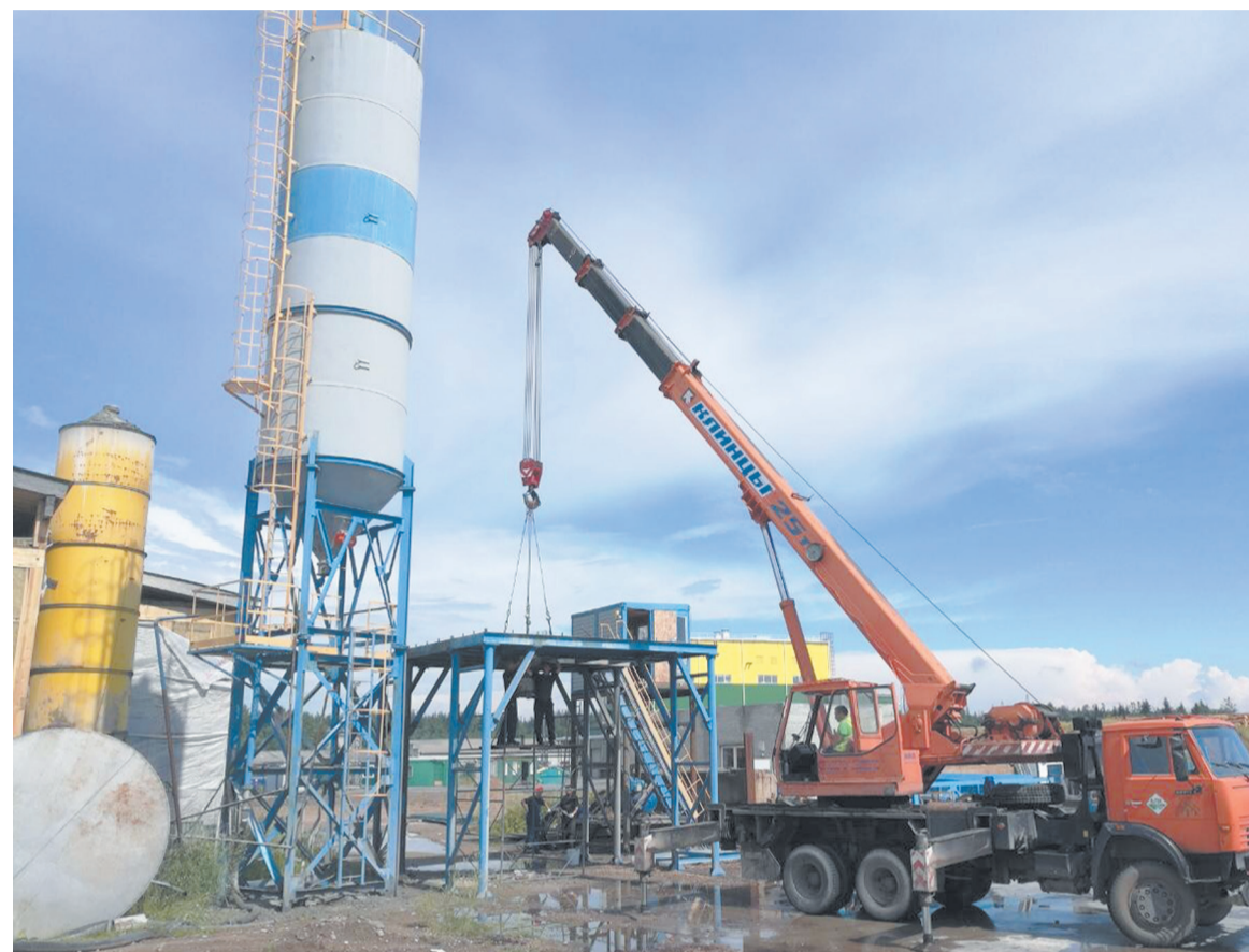
Демонтаж бетонного завода
