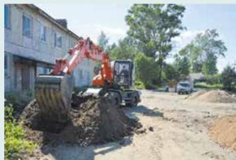
Ремонт инженерных сетей в поселке Октябрьский идет полным ходом. Завершены работы на ул. Клубная с заменой 200 метров сетей отопления, горячего и холодного водоснабжения. Также проложено 128 метров новых сетей в переулке Октябрьский, 60 метров отопления и горячего водоснабжения на ул. Ломоносова, на территории районной больницы - 75 метров. В ближайших планах замена водопроводных сетей на ул. Коммунальная и сетей водоотведения на ул. Заводская.
