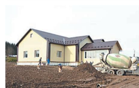
На строительстве нового Дома культуры завершены все наружные работы: полностью обшито здание, распланирована территория, объект подключен к тепло- и водоснабжению. Внутри здания продолжаются отделочные работы.
