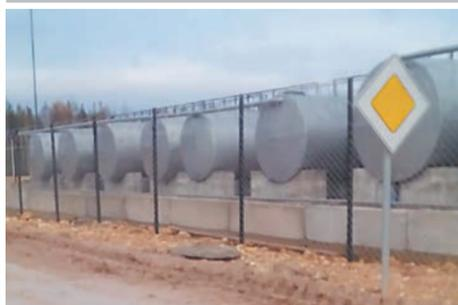
На территории Плесецкого терминала завершаются работы по строительству нового склада ГСМ общим объемом 550 тонн и заправочной станции. Здесь можно будет принимать и выгружать 8 железнодорожных цистерн одновременно, что обеспечит необходимый запас топлива для стабильной работы техники предприятия.
