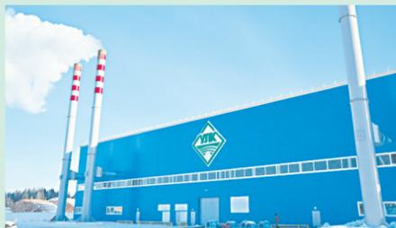
На стройплощадке будущего завода по переработке тонкомерной древесины подходят к завершению все работы на новой котельной мощностью 45 Мвт. Два котла уже запущены в работу, еще два работают в тестовом режиме под контролем итальянских специалистов – представителей компании – поставщика оборудования.
